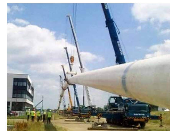
Leiding met een binnendiameter van 1 meter wordt in een booggat onder het kanaal van Willebroek getrokken (onderdeel van leiding Walem-Tisselt)
