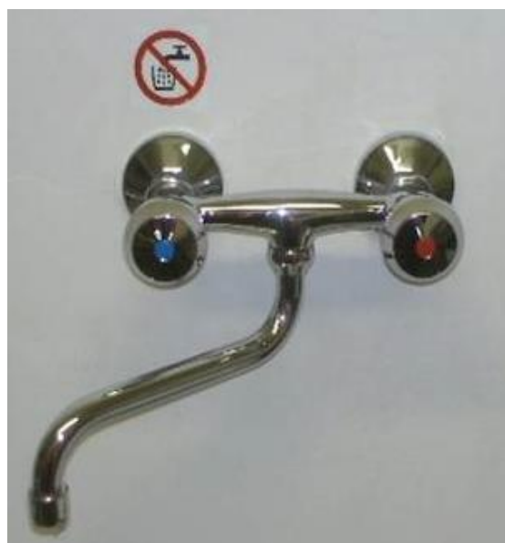
Figuur 4: wanverbinding mengkraan
