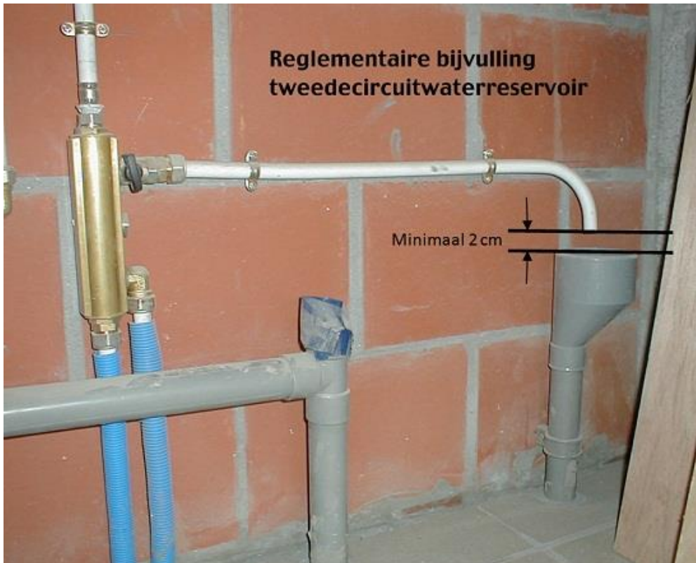
Figuur 3: AA-beveiliging bijvulinstallatie (Bron: VMM)
